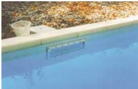
2. Dépôt de graisse à la ligne d'eau à cause d'une mauvaise aspiration par les skimmers.
