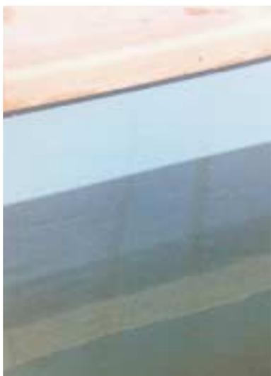
8. Utilisation d'une bande adhésive non-compatible avec la membrane.
