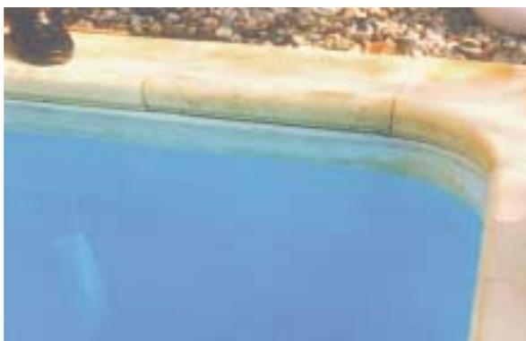
1. Formation d'un dépôt calcaire à la ligne d'eau.
