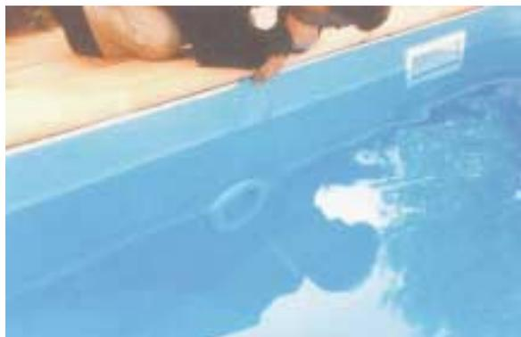
10. Altération de la membrane d'étanchéité par des produits chimiques trop agressifs.
