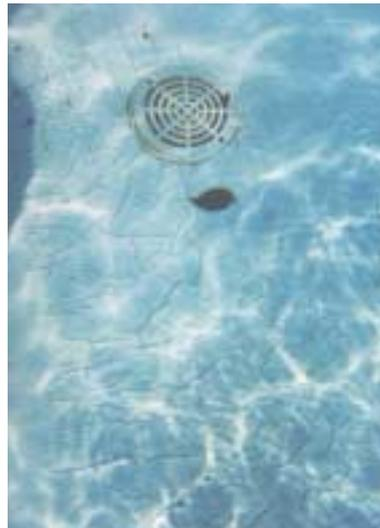
12. Formation de plis dus à un mélange insuffisant des produits chimiques dans l'eau.
