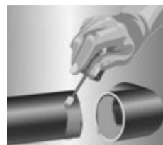
APPLICATION du polymère de soudure
