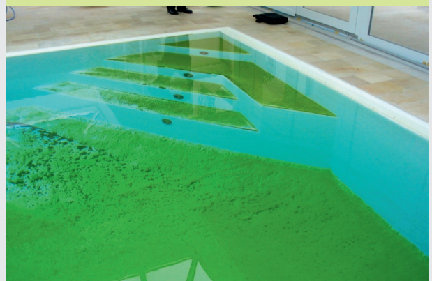
Piscine avec une forte présence d'algues
