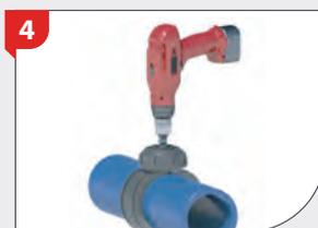
4 Effectuer le perçage du tube (hors charge) à l'aide d'un outil approprié.
