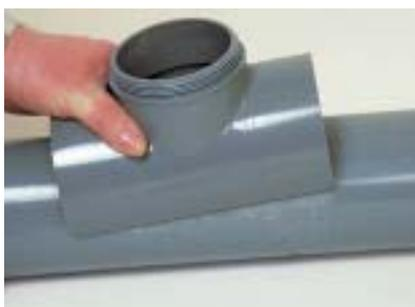
Mettre en place la selle sur le tube et laisser sécher une vingtaine de minutes.
