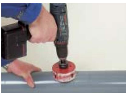
A l'aide d'une scie cloche, découper l'ouverture dans la canalisation.
