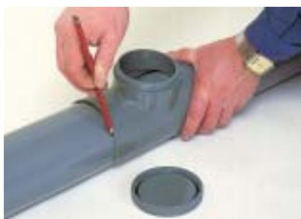
Repérer sur le tube la position de la selle et du trou à percer.
