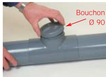
Le bouchon de visite de la selle de réparation permettra éventuellement un futur nettoyage sans avoir à repercer la canalisation.
