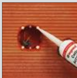
Scellement par colle nettoyable à l'eau
